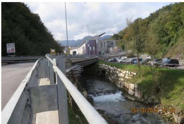
Il secondo ponte, che ha una lunghezza di circa 60 m, divisa in tre campate, è realizzato in conglomerato cementizio armato. I sostegni in alveo sono costituiti da due semplici colonne circolari con mensole, l'impalcato è molto compatto in altezza ed ha l'intradosso piano; i bordi del ponte sono rivestiti con velette inclinate per ridurre ulteriormente l'impatto di prospetto.
