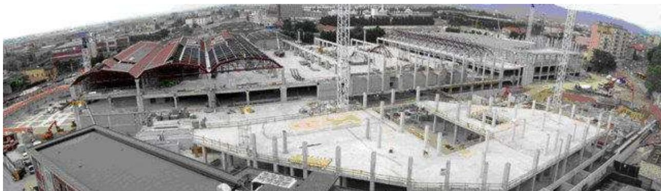
Ne è derivata una forma strutturale molto irregolare e complessa, alla quale era necessario dare i necessari requisiti di resistenza sismica, sulla base della classificazione del territorio comunale e delle più recenti norme sismiche.
